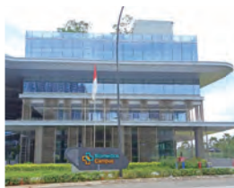
ジャカルタ BSD 校
